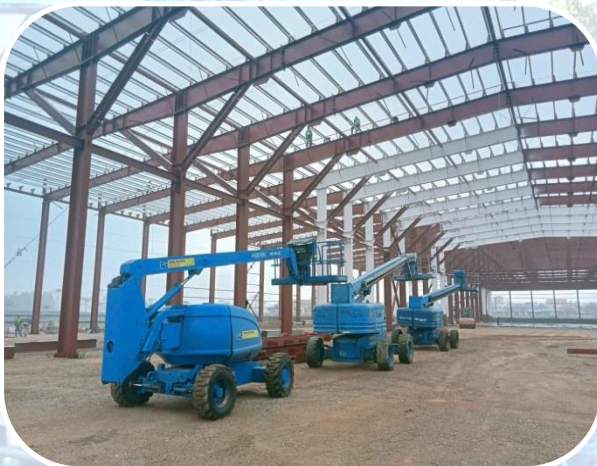
Dự án BW Thuận Thành - Bắc Ninh
